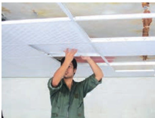
شکل ۱۷- نصب و تنظیم پنل در شبکه فلزی
