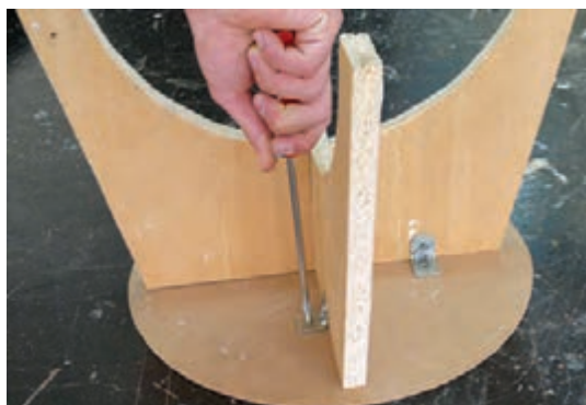
شکل ۶۷- مراحل مونتاژ چهارپایه
