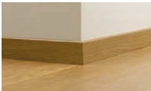
شکل ۷۶ - اتصال قرنیز در کنج به صورت فارسی
