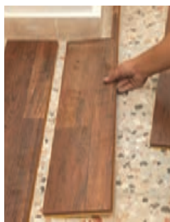
شکل ۹۰ و ۹۱ - قفل کردن قطعات لمینت به یکدیگر
