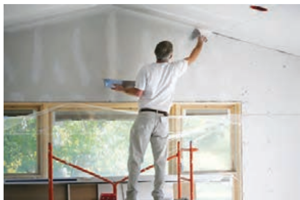
شکل ۱۸- پرداخت درز بین دیوار و سقف کاذب
