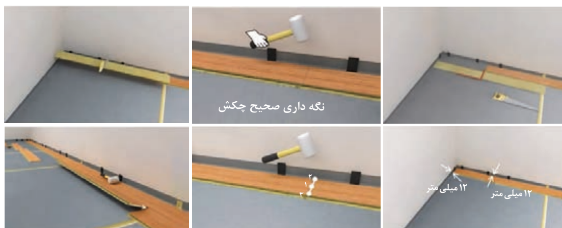
شکل ۳۷ تا ۴۲- نصب ردیف اول و دوم کفپوش لمینت بر روی فوم
