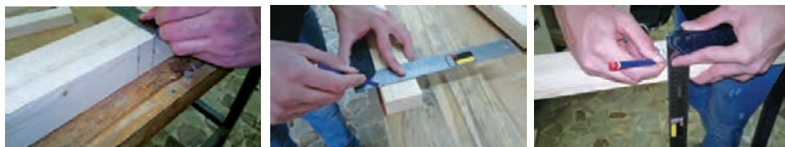
شکل ۴۴- خط‌کشی و انتقال اندازه‌ها به ضخامت چوب
