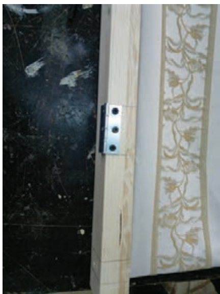
شکل ۷۲- محکم کردن برگه اول لولا با ۳ پیچ
