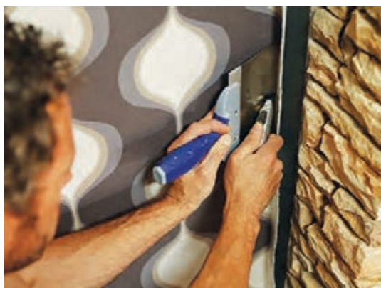
شکل ۸۵- برش اضافه پارچه روی دیوار
